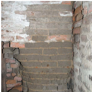
SPALLING
