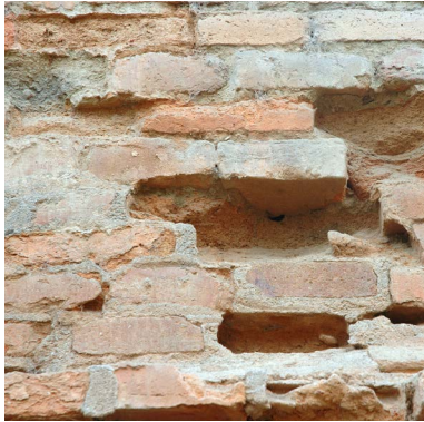
SPALLING
